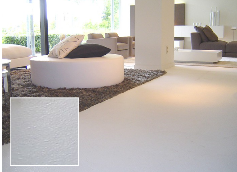
Bij een vlokkenvloer bepaalt de grootte, kleur en hoeveelheid van de ingestrooide vlokken het uiterlijk van de vloer
