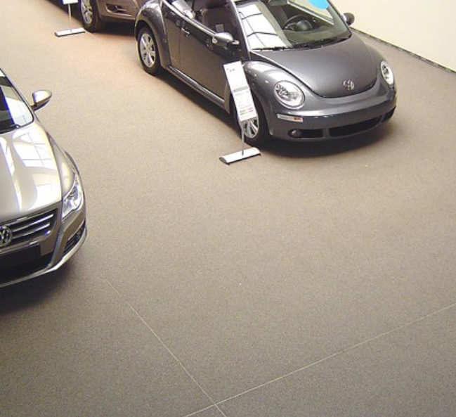
Een steentapijt is weliswaar een naadloze vloer, maar voor grote oppervlakten zijn evenwel uitzettingsvoegen vereist
