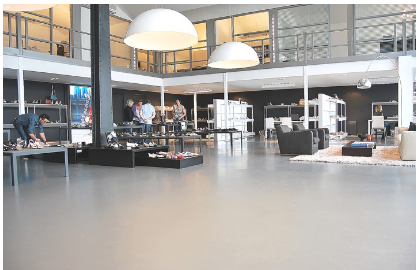
Door zijn soepelheid is een PU-gietvloer aangenaam om over te lopen. Polyurethaan is bovendien UV-bestendig, geluidsabsorberend en voelt warm aan
